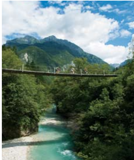
Hängebrücke im Soča-Tal (1. Etappe)
